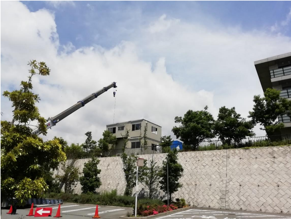
② 仮設現場事務所を設置しました。(2021年5月22日撮影)
