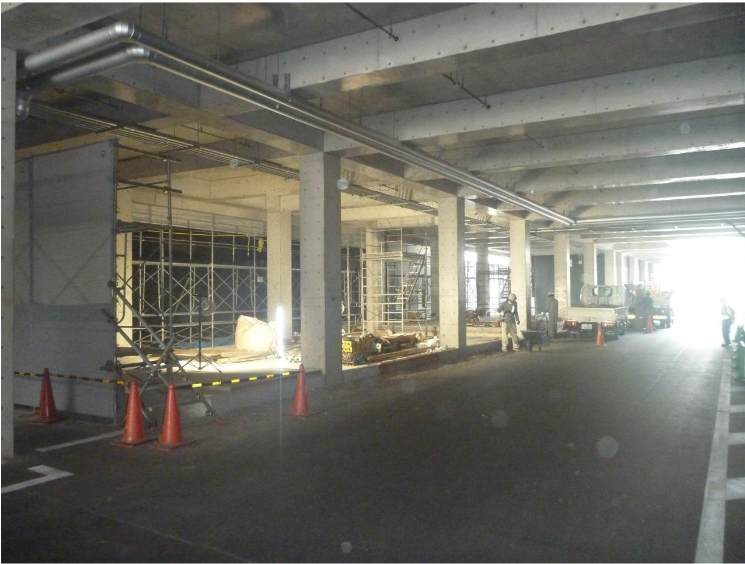
①基礎工事が始まりました。(2021年4月26日撮影)
