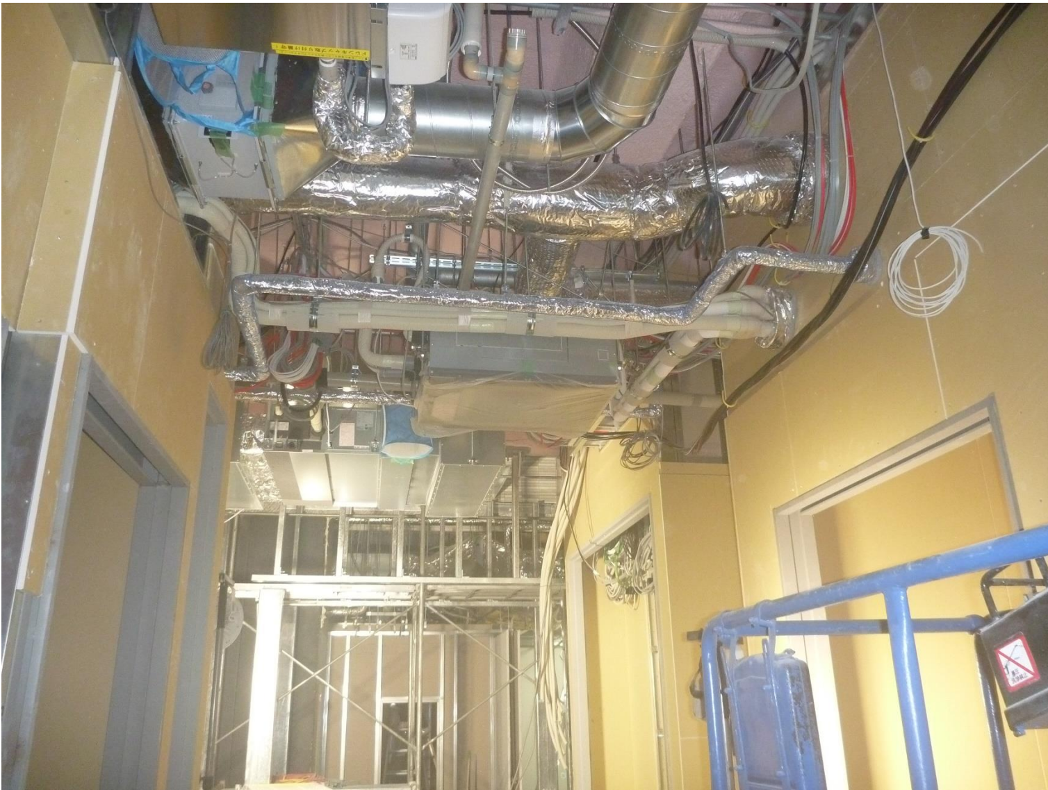
③内部設備工事が進んでいます。(2021 年 7 月 1 日撮影)
