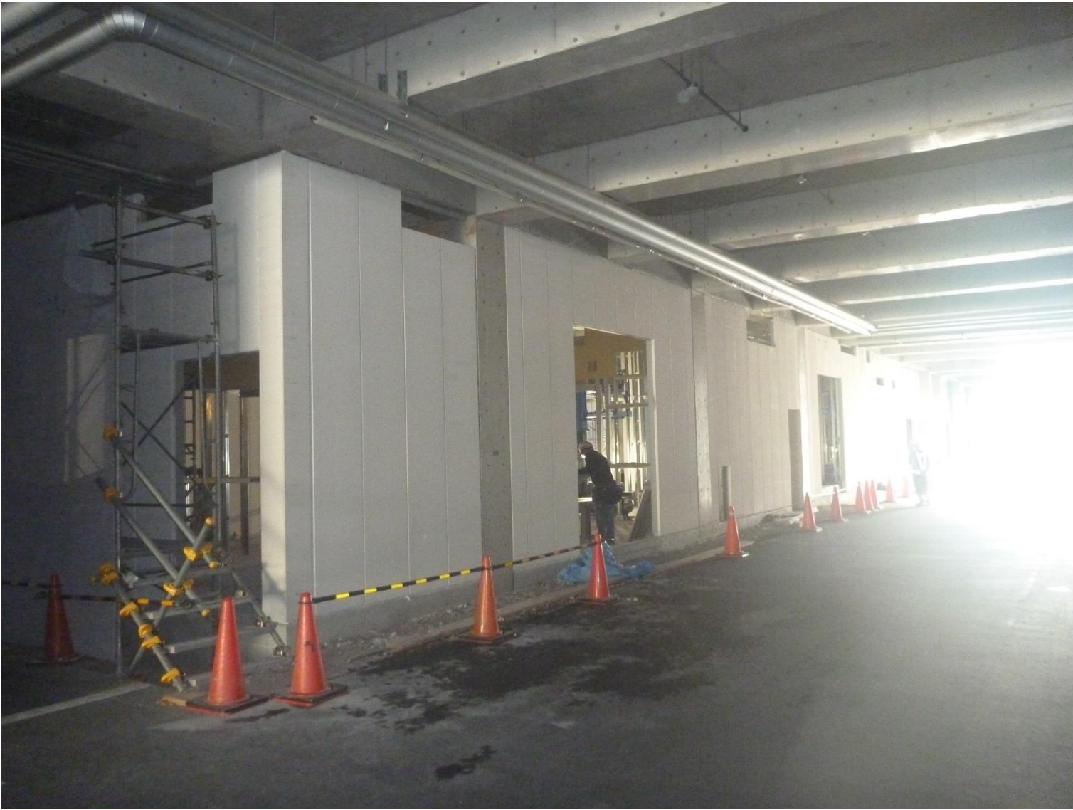
②外壁のALCパネルがほぼ出来上がりました。(2021 年 5 月 31 日撮影)
