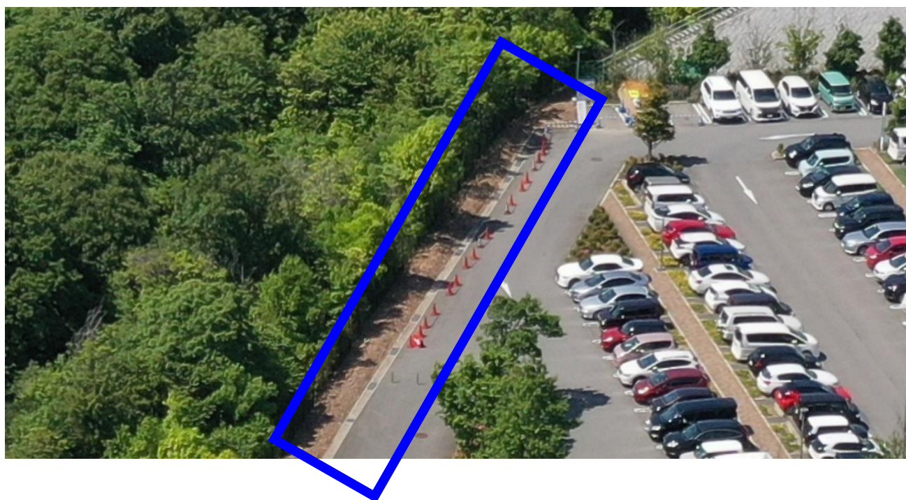
③ 雨水排水の整備工事を開始しました。(2021 年 6 月 3 日撮影)
