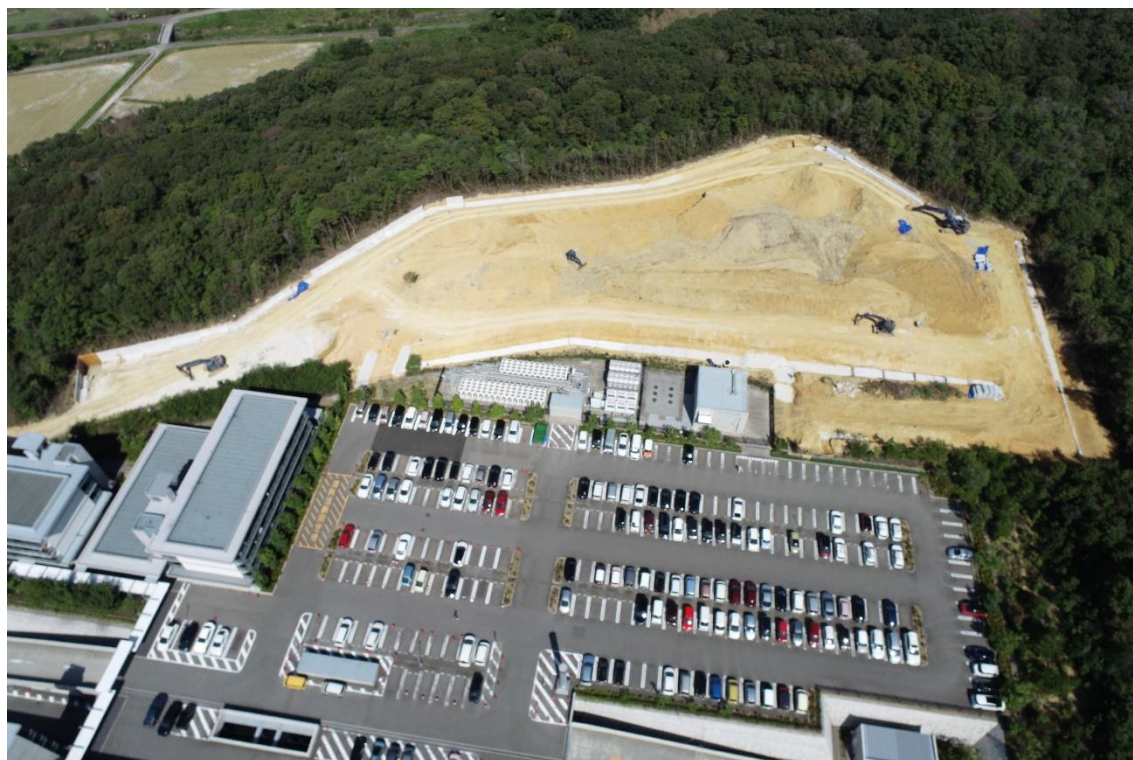
⑦ 整地作業が始まりました。(2021年10月2日撮影)
