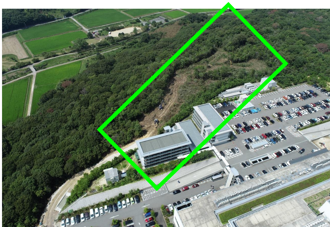
⑤ 駐車場部分の伐採作業が始まりました。(2021 年 8 月 2 日撮影)
