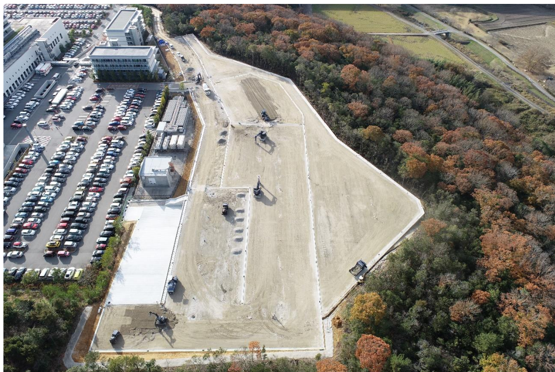
⑨ 整地工が進んでいます。(2021年12月6日撮影)
