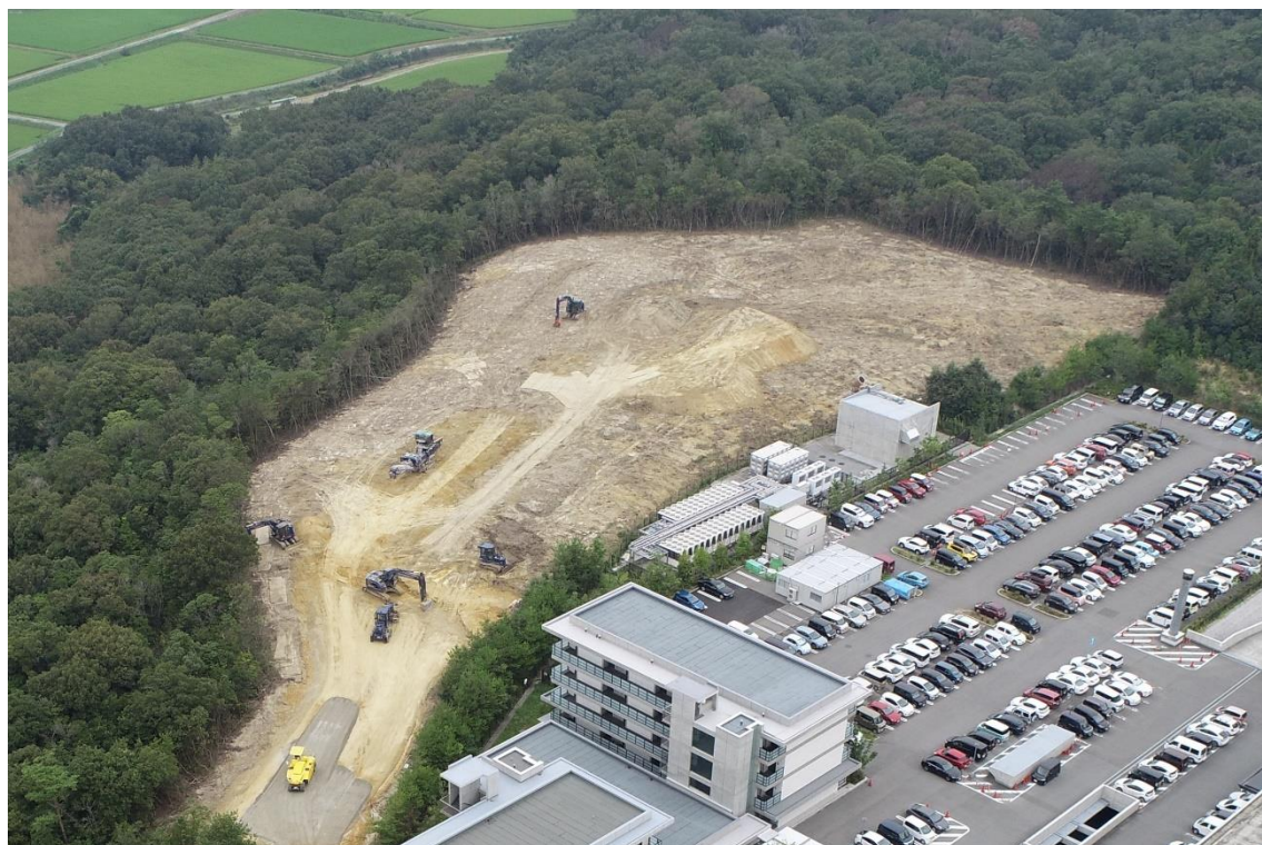
⑥ 伐採作業が進んでいます。(2021年8月31日撮影)
