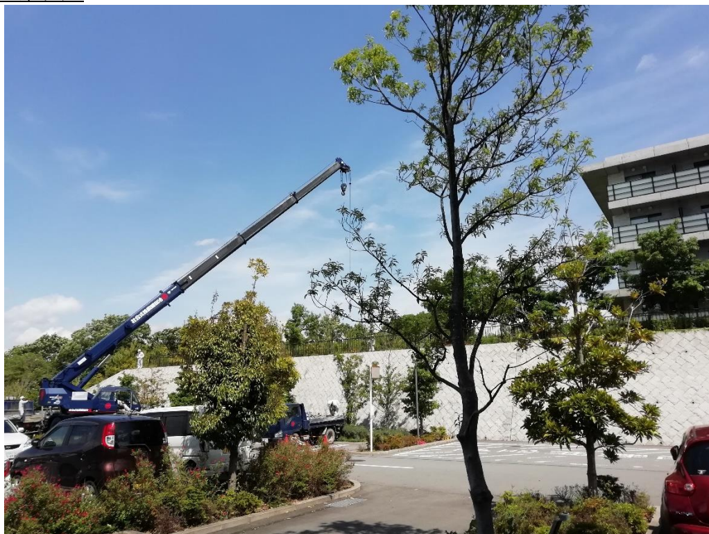
① 仮設現場事務所を設置するため宿舎棟西側部分の整備を開始しました。(2021 年 5 月 15 日撮影)
