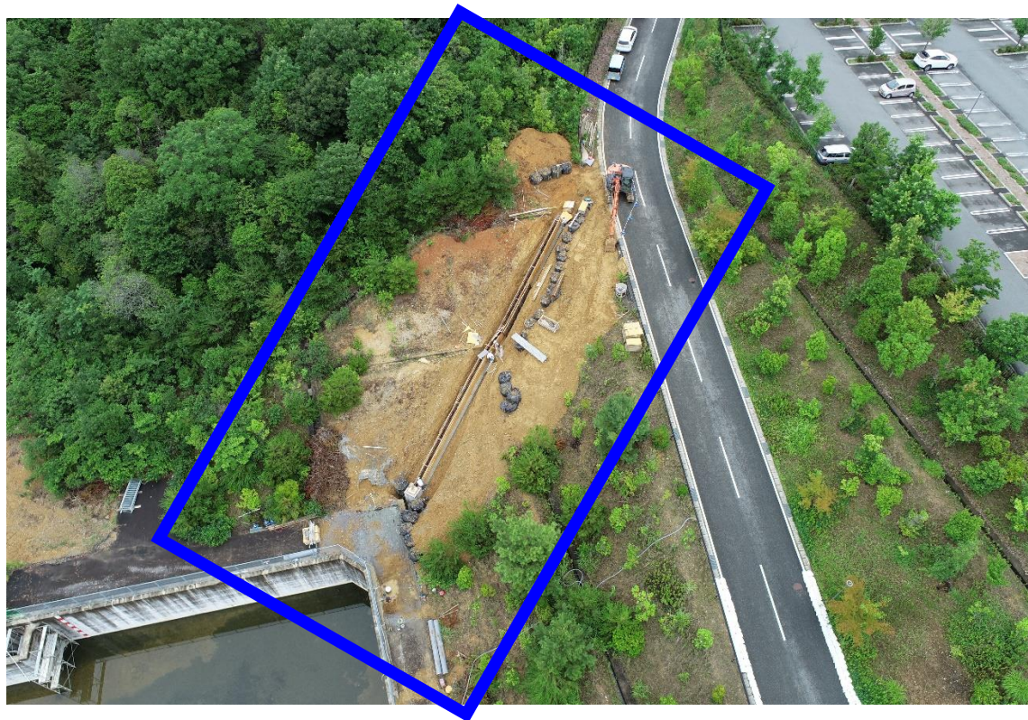
④ 雨水排水の整備工事が進んでいます。(2021 年 7 月 3 日撮影)
