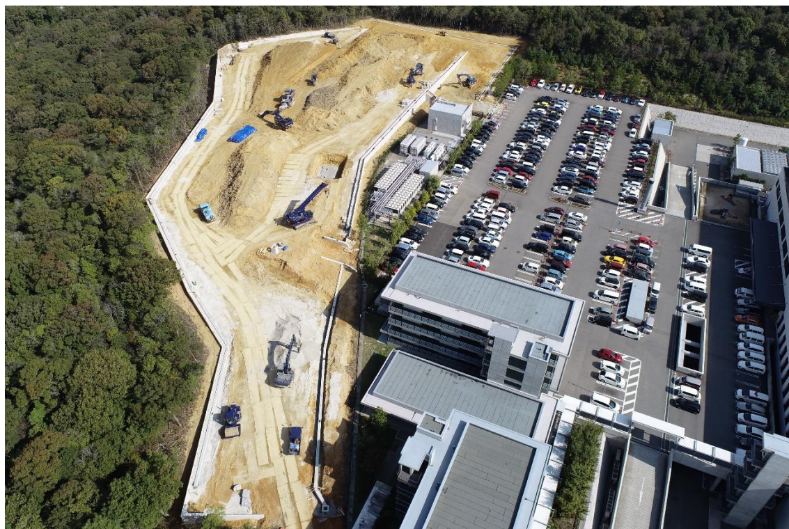
⑧ 擁壁の工事が進んでいます。(2021年11月2日撮影)
