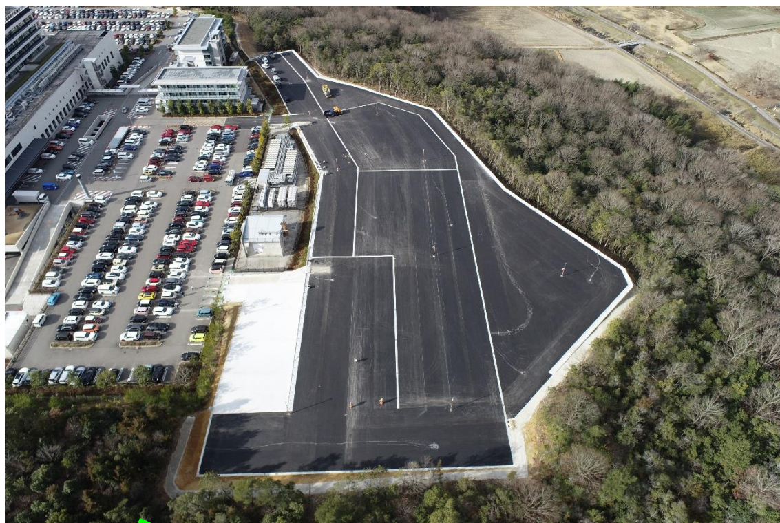
⑩ アスファルト舗装が完成しました。(2022 年 1 月 7 日撮影)
